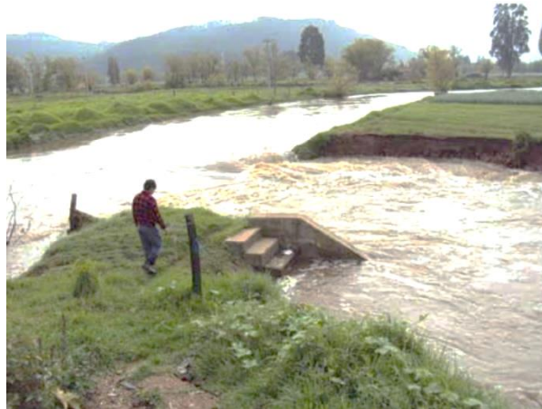
Ilustración 2. Ruptura jarillón del Río Chicamocha y desbordamiento del Canal Vargas. Fuente: CLOPAD Duitama, 2010.
